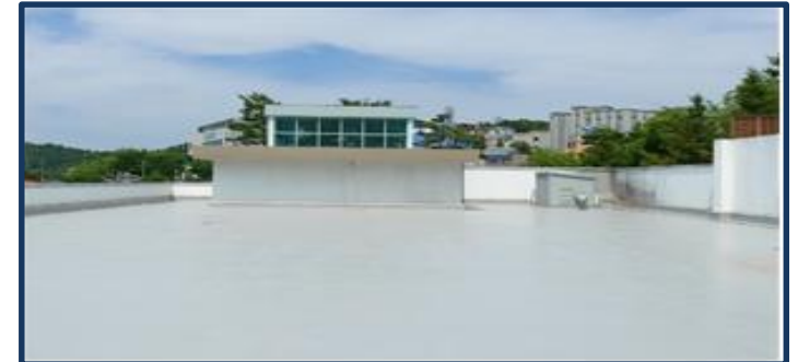
옥상 방수 공사
